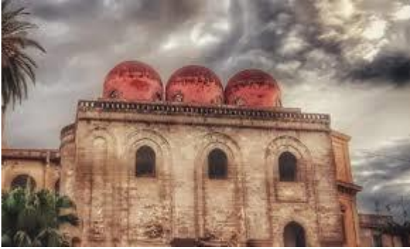
Figura 43. S.Giovanni degli Eremiti, particolare dell'esterno
